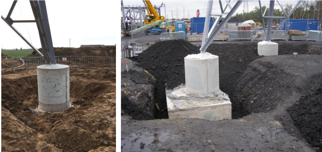
Abbildung 10: Anbindung der Eckpfähle nach dem Betonieren
