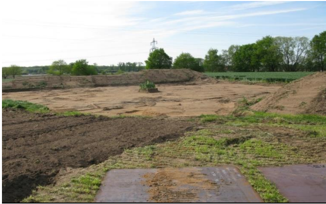
Abbildung 4: Abtrag des Oberbodens und temporäre Bodenmieten
