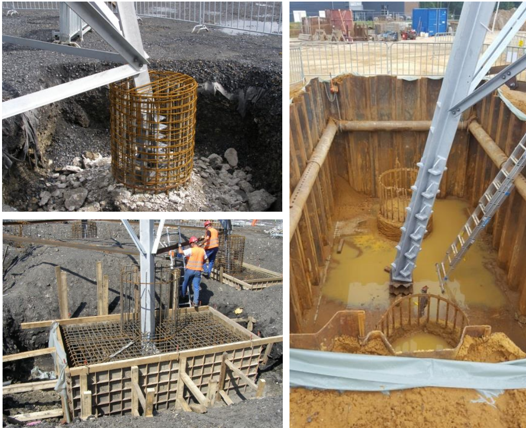
Abbildung 9: Anbindung der Eckpfähle vor dem Betonieren
