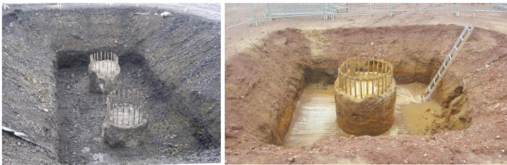
Abbildung 6: Freilegen der Bohrpfähle
