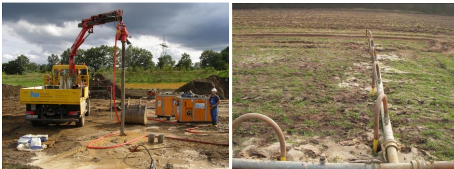
Abbildung 7: Einrichtung der Wasserhaltung mittels Spüllanzen
